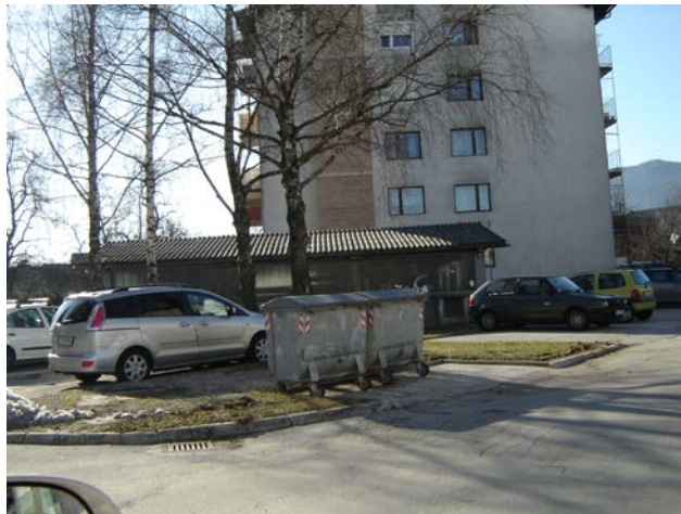
Slika 8: kotlovnica Prijateljev trg
