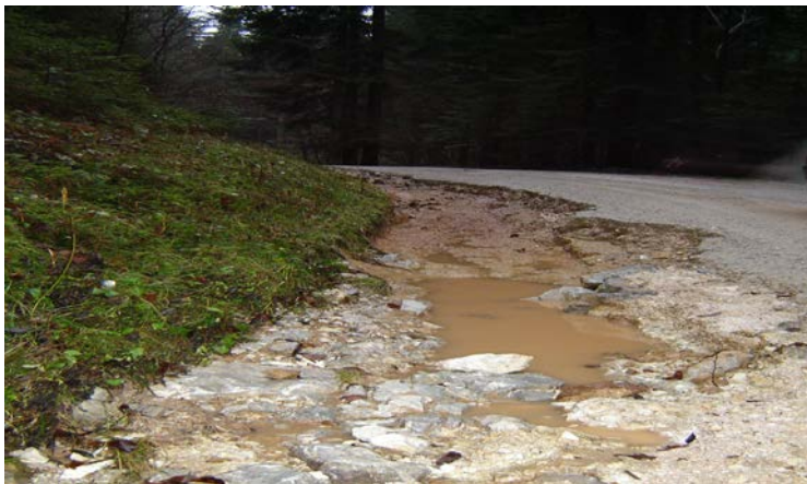
Slika 9: vzdrževanje lokalnih in javnih poti
