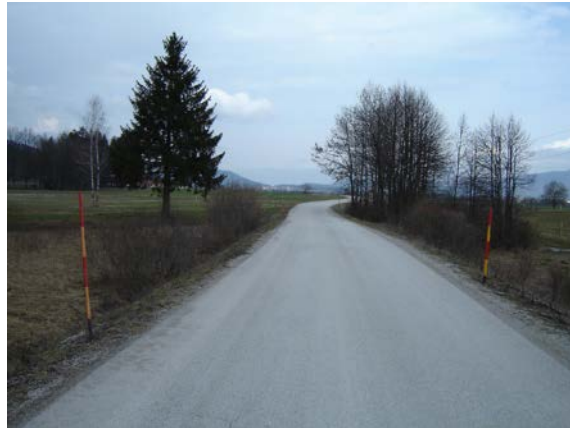
Slika 13: vzdrževanje lokalnih in javnih poti
