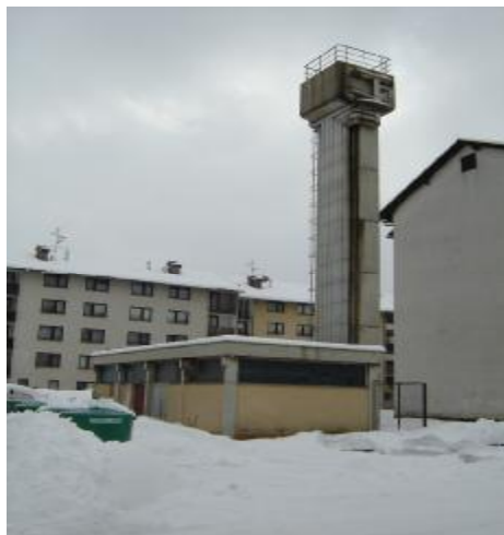
Slika 6: kotlovnica Knafljev trg
