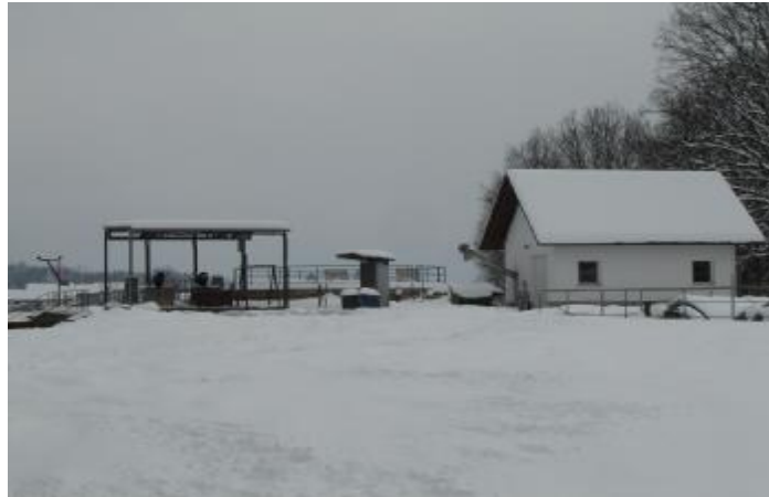
Slika 1: čistilna naprava Ribnica
