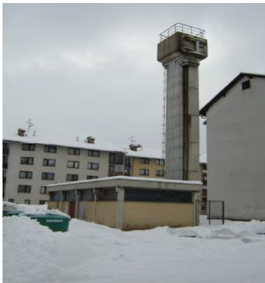
Slika 6: kotlovnica Knafljev trg
